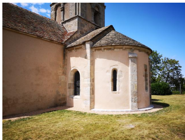
Abside après intervention
